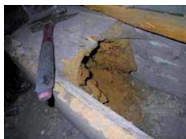
zerstörte Fußschwelle
