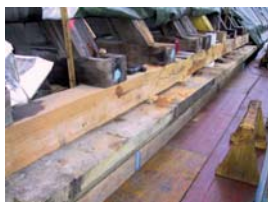
nach erfolgreicher Sanierung
