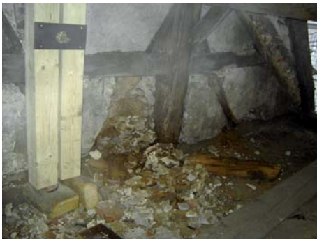
Notsicherung einer Fachwerkwand
